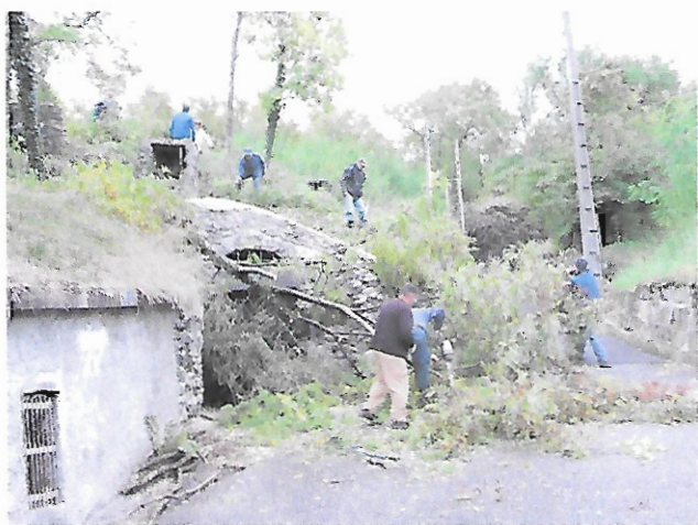
Abattage d'arbres rue des Grandes Caves
