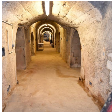
Couloir Savaron après rénovation
