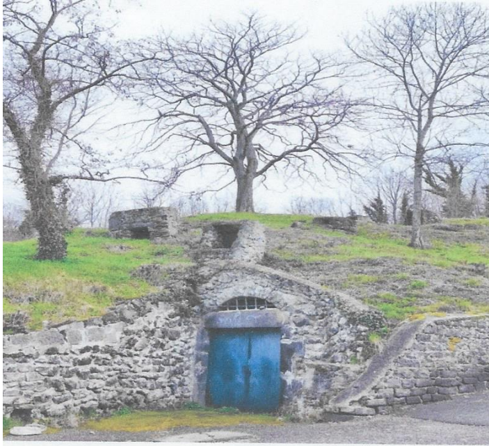
Entrée d'une cave d'Aubière et chapeaux des soupiraux d'aération.
