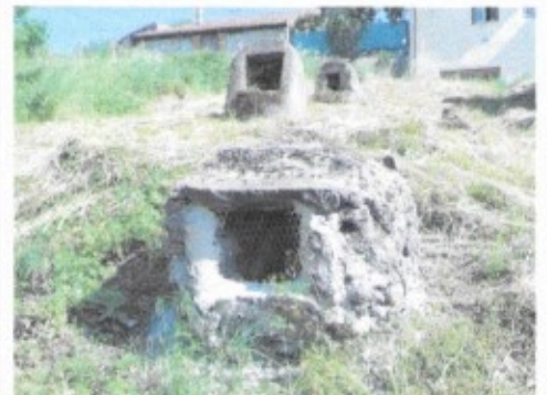
Soupiriaux entre les rue du Paradis et de l'Adèle
