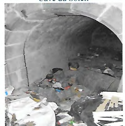
Déblaiement avant la restauration
