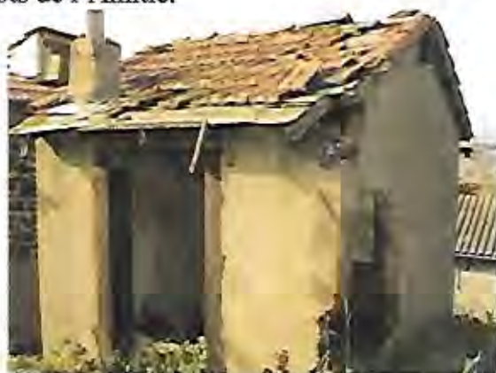
La tonne avant sa réhabilitation
