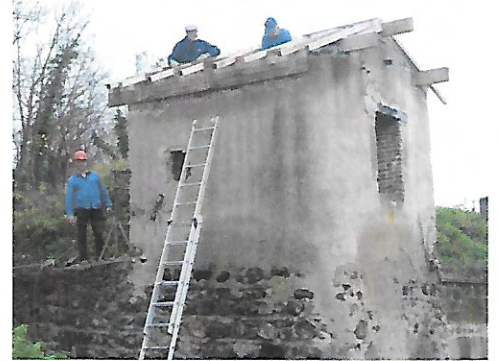
Rénovation de tonne
