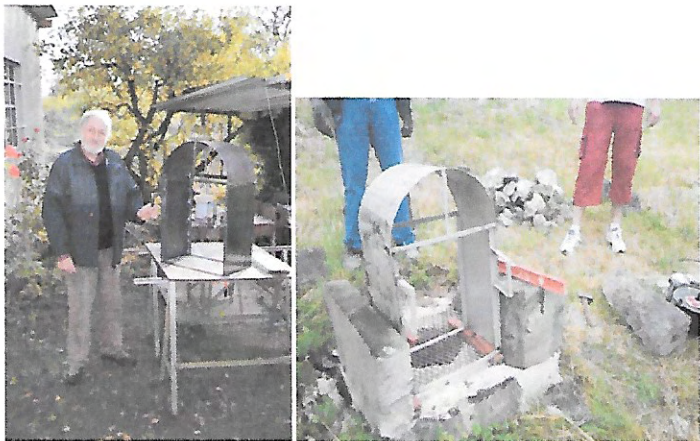
Robert Wherling et son gabarit et réfection d'un soupirail à l'aide de ce gabarit
