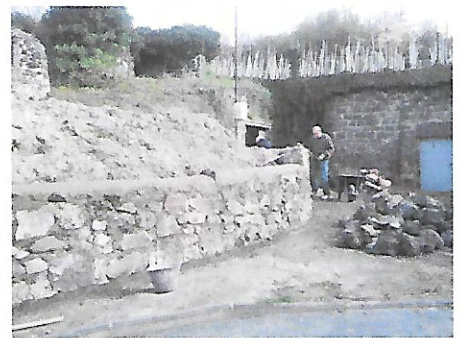
Mur de soutènement
