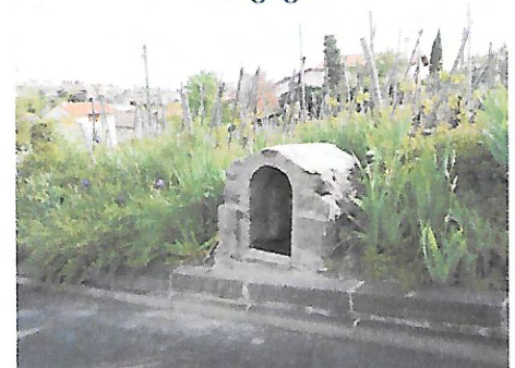
Réfection de soupirail
